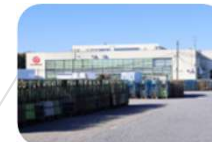
Kasumi Sakura Distribution Center (Land)
