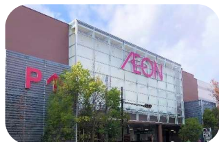
外壁塗装工事
